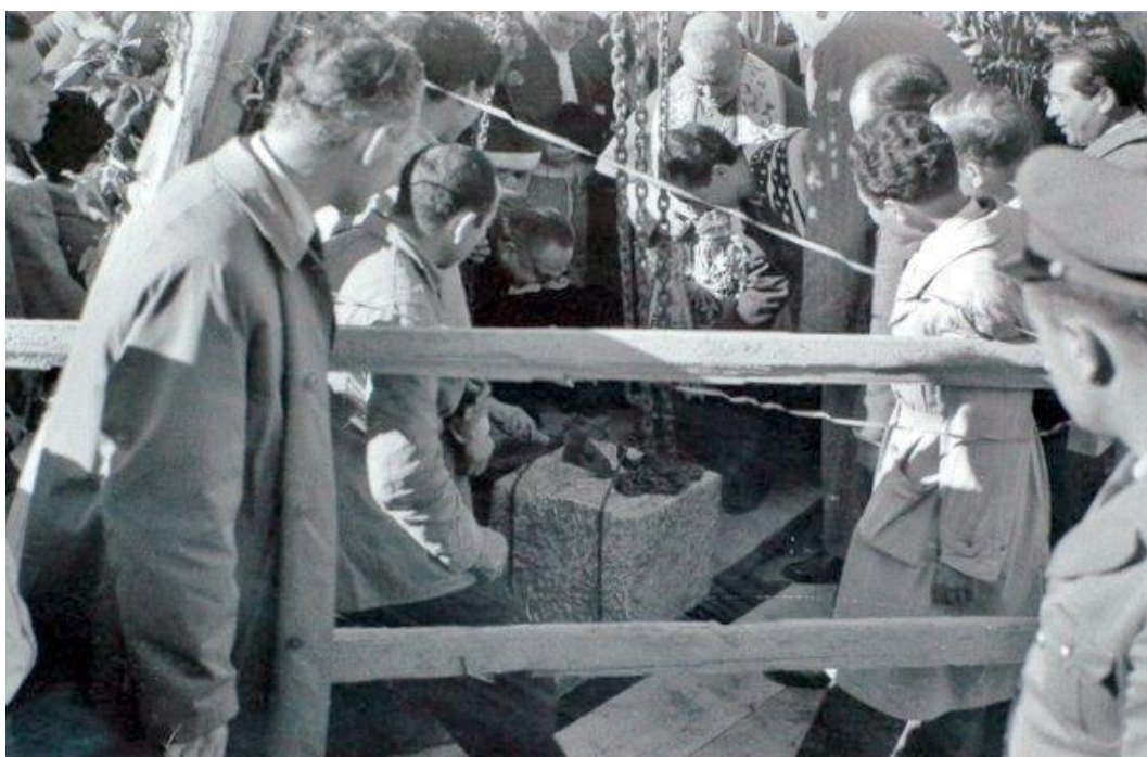
Figura 15: il sindaco Rocco Scotellaro assiste alla posa della prima pietra per la costruzione dell'edificio scolastico di viale Regina Margherita alla presenza di mons. Raffaello delle Nocche, vescovo di Tricarico e dell'on. Emilio Colombo, sottosegretario di Stato per l'Agricoltura e Foreste, Tricarico, 13 novembre 1949. Foto tratta dal sito web del Centro di Documentazione "Rocco Scotellaro e la Basilicata del secondo dopoguerra" Tricarico, http://www.centrodocumentazionescotellaro.org/mostra_Scotellaro.asp
